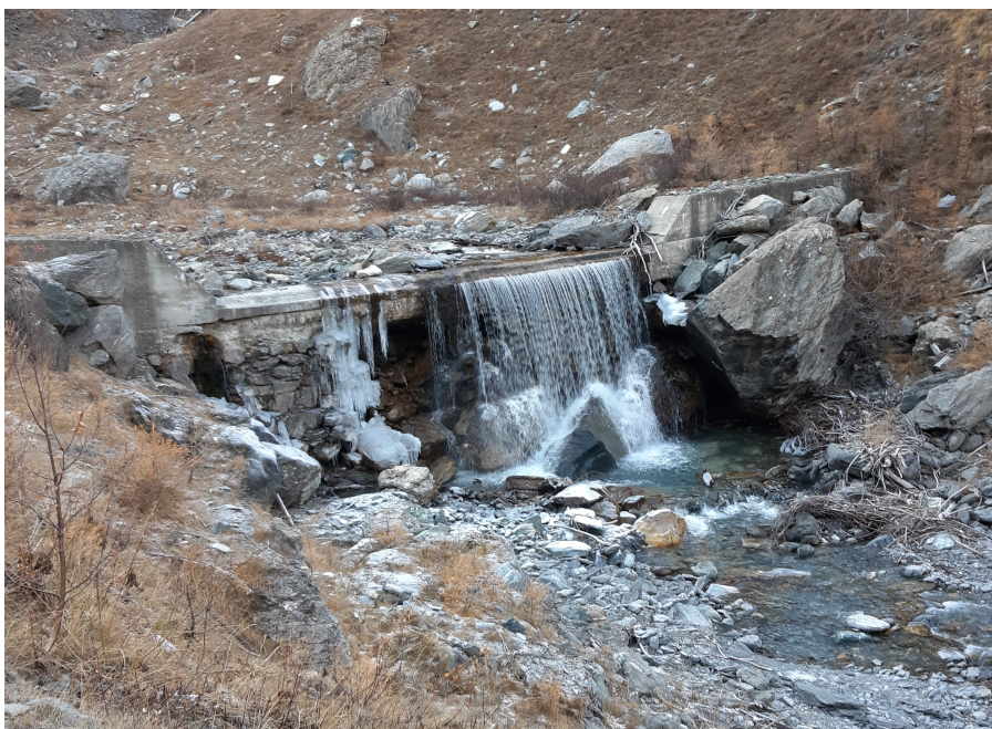
Figura 1.5: INQUADRATURA 2 Tratto 1 intervento: rimozione Briglia n. 7 e realizzazione step-pool
