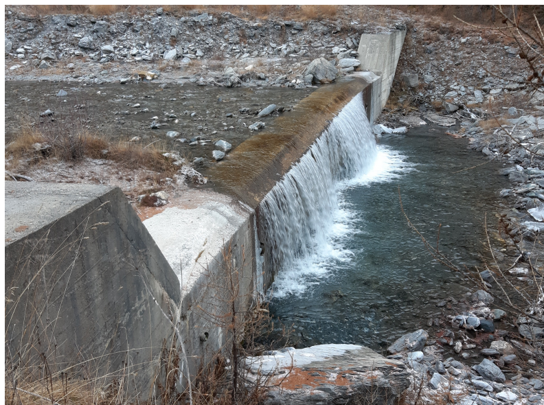
Figura 1.8: INQUADRATURA 5 Tratto 2 intervento: rimozione Briglia n. 4 e modellazione del fondo alveo a pendenza naturale
