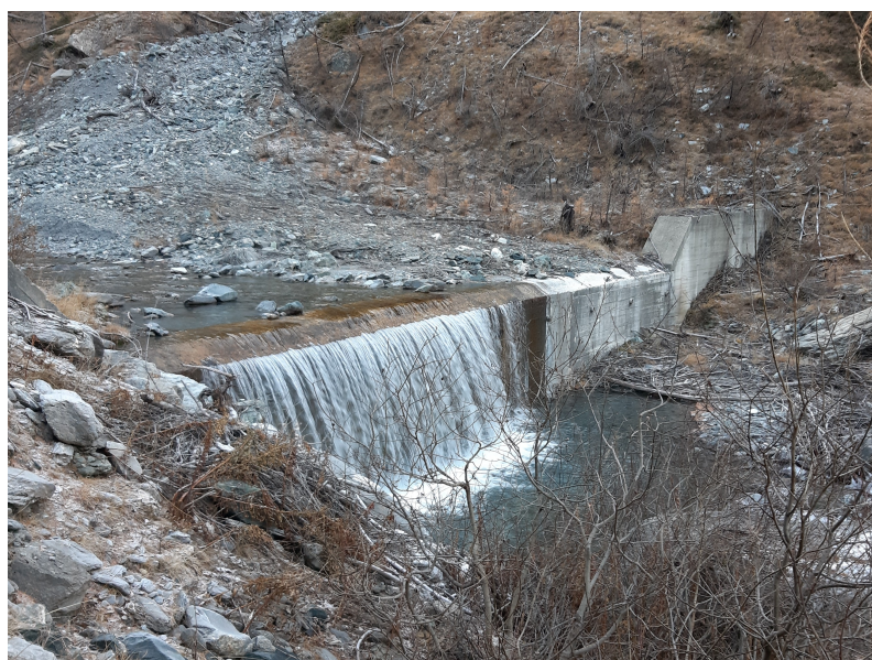
Figura 1.9: INQUADRATURA 6 Tratto 2 intervento: rimozione Briglia n. 3 e modellazione del fondo alveo a pendenza naturale
