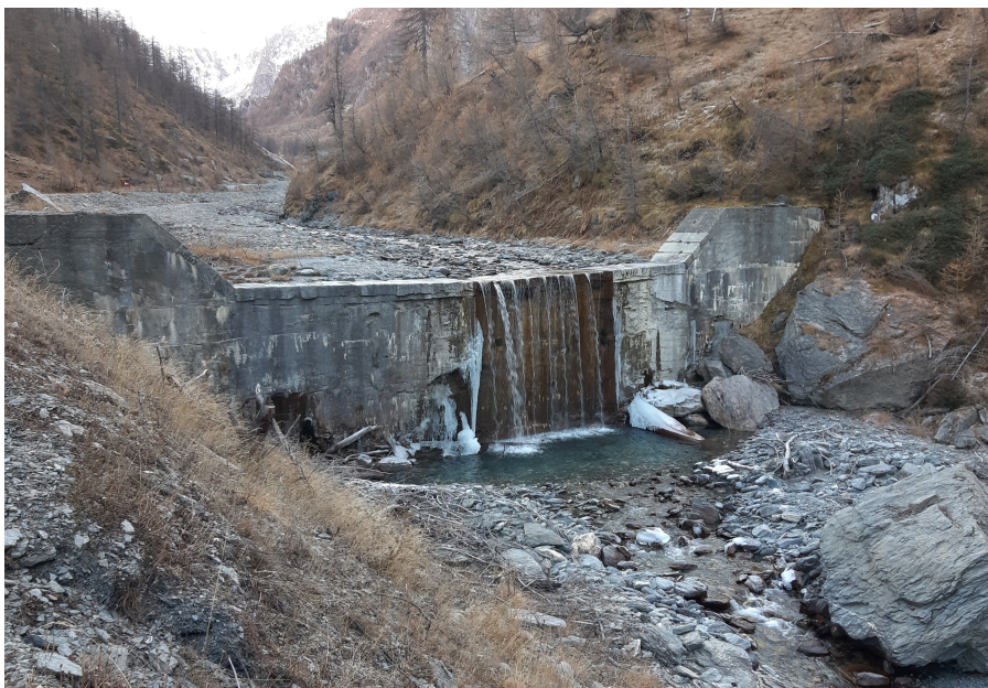
Figura 1.4: INQUADRATURA 1 Tratto 1 intervento: rimozione Briglia n. 8 e realizzazione step-pool
